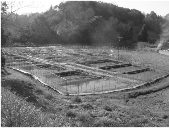
写真1 保護池の全体
